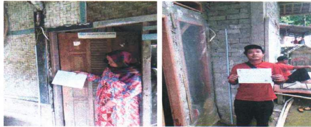
Bantuan Elektrifikasi kepada 110 Rumah tangga yang belum teraliri listrik di Kabupaten Purwakarta
