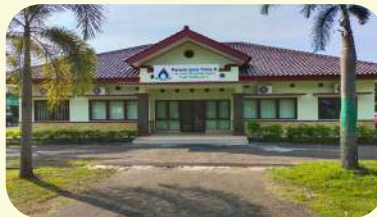
KANTOR UNIT WILAYAH V / Regional Unit Office V Komplek Perumahan Cimanuk No 105 Karyamulya Kec. Kesambi Kota Cirebon
