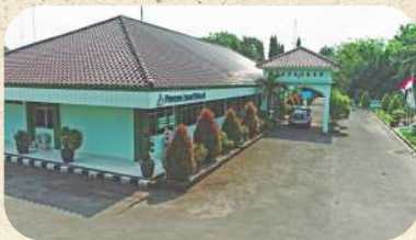
KANTOR UNIT WILAYAH I / Regional Unit Office I Jalan Ir. Djuanda No. 124D, Bekasi - Jawa Barat Telp & Fax. (021) 880 1884
