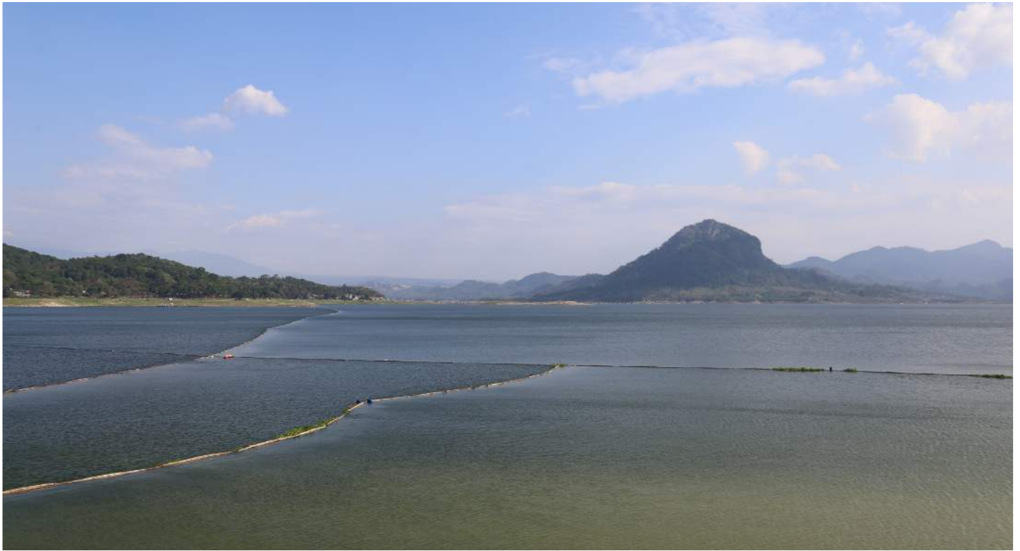
Waduk Jatiluhur Setelah dilakukan pembersihan
